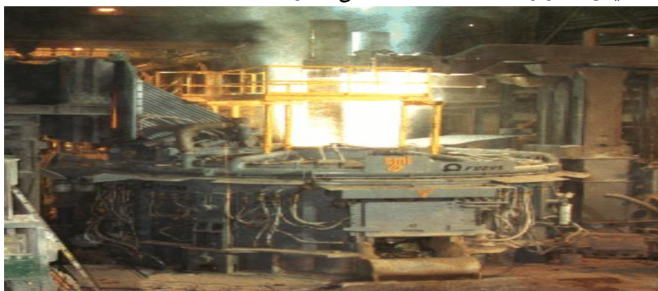
شکل ۱-۲- نمای از ساختمان کوره قوس
