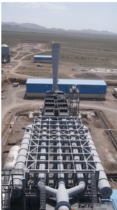
نمای فوقانی Reformer, Heat Recovery & Stack
