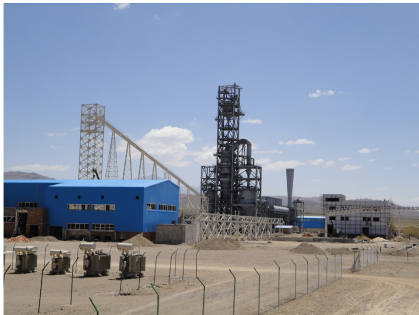
نمای غربی پروژه
