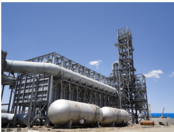
نمای شمالی ریفرمر و مخازن گاز تصفیه (Purgr Gas Tanks)
