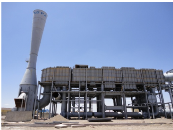
نمای شمالی سیستم بازیابی گرما و دودکش
