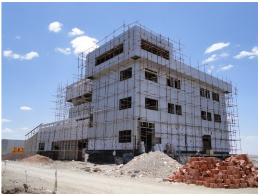
اتاق کنترل (Control Room)
