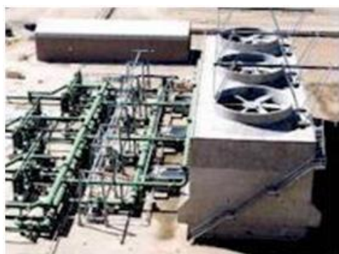
شکل 11- 25: تصاویری از Cooling Tower های دمنده
