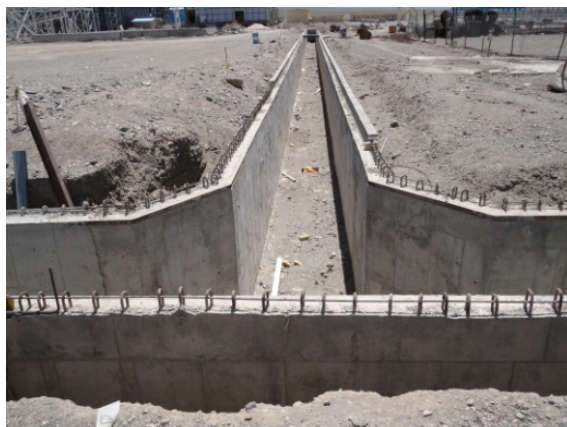
کانال های برق (Cable Trench)
