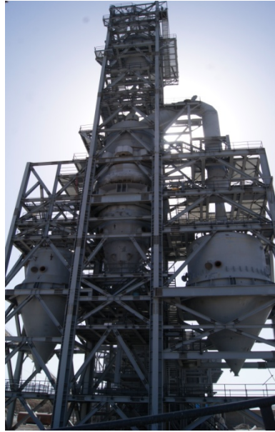
نمای شرقی کوره
