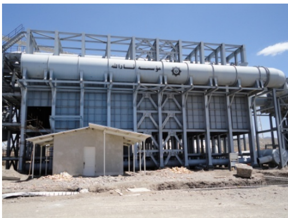
نمای جنوبی ریفرمر و ساختمان آنالیز گاز
